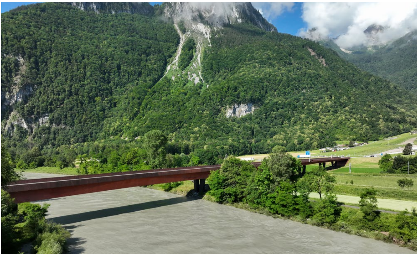
Das Viaduc des Evouette verbindet im unteren Rhonetal die Walliser und die Waadtländer Seite.
